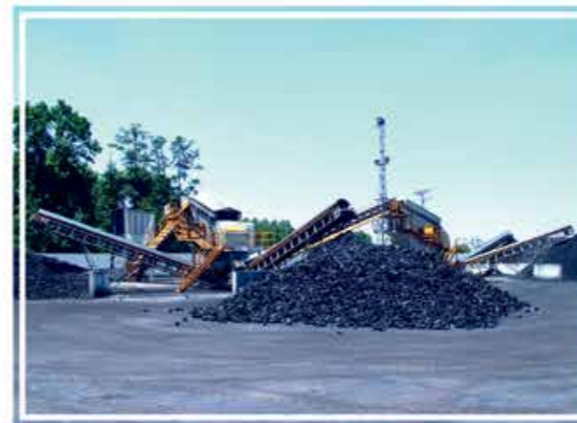
KÖMÜR ELEME ve SINIFLANDIRMA TESİSLERİ
