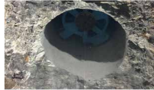
Resim-1: Mekanik kazı sonrası kuyu cidarı
