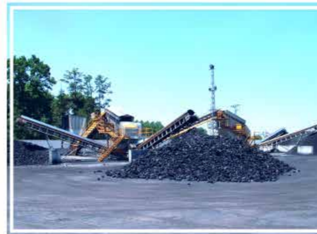
KÖMÜR ELEME ve SINIFLANDIRMA TESİSLERİ
