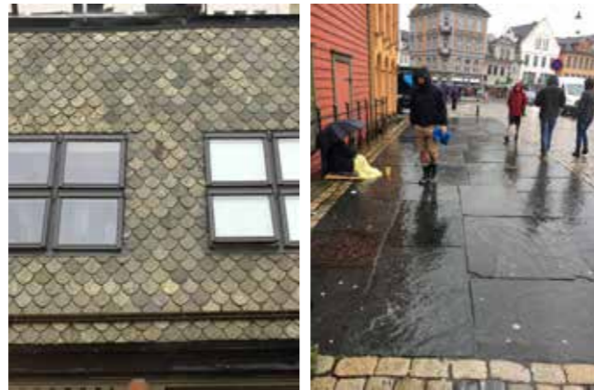
Norveç Bergen'de Arduvaz - Kayrak taşından Çatı uygulaması
