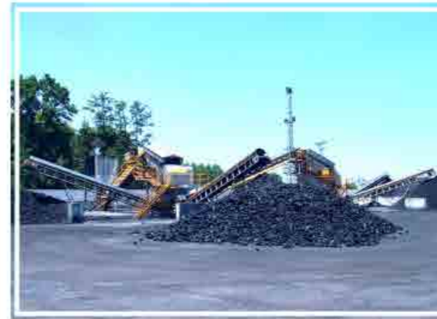
KÖMÜR ELEME ve SINIFLANDIRMA TESİSLERİ
