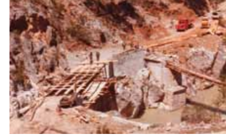
Yeni Dalaman Köprüsü inşa halinde. Sağda eski köprüünün yeri ve geçici yaya köprüsü görülüyor.
