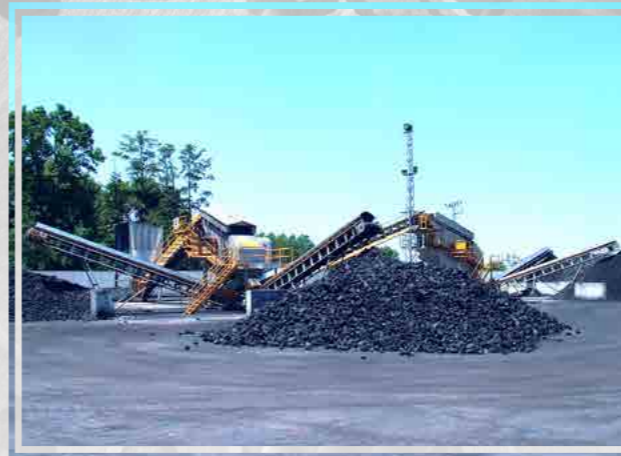
KÖMÜR ELEME ve SINIFLANDIRMA TESİSLERİ
