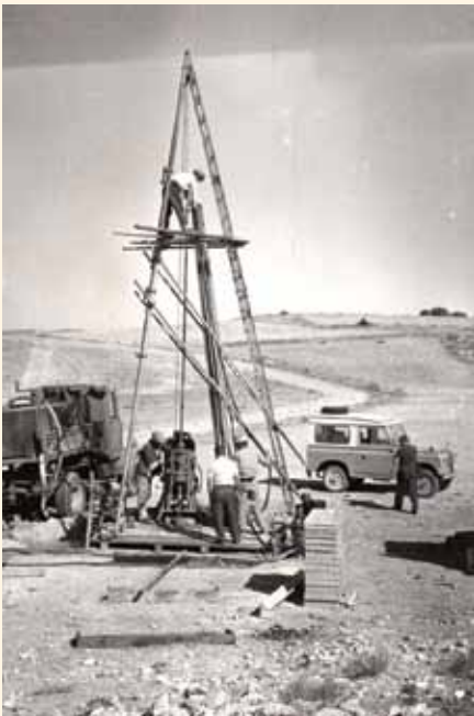
Resim 3- Sarıkaya yamaçlarında şirketin yaptığı sondaja ait kule ve teçhizat
