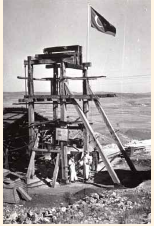
Resim 4- Sarıkaya Maden yatağı üzerinde açtığımız 60 metre derinliğinde düşey kuyu. (Kuyu 18 metreden sonra 40 metre cevher içine inmiştir. Kuyu kulesinin ağaçları Eski Susurluk Madenindeki kuyudan sökülüp getirilmiştir.)
