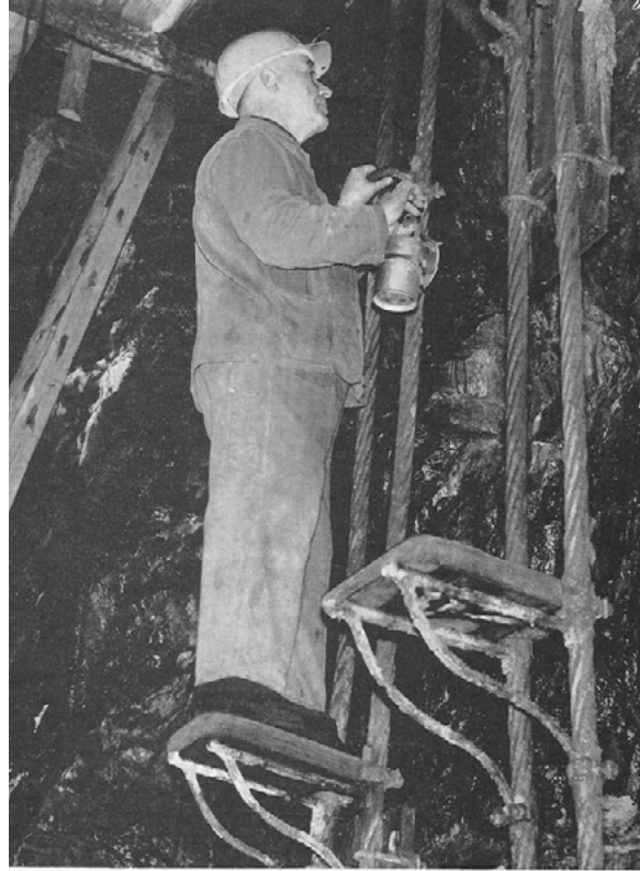
Die noch in Betrieb befindlich Fahrkunst in St. Andreasberg in 190 m Tiefe. (aus Skiba, Moderner Harzer Bergbau)
