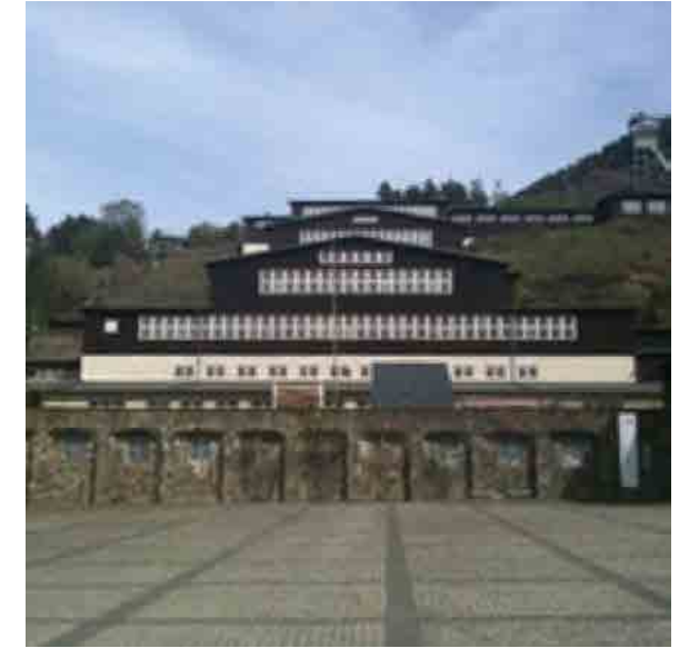
Resim 1 - Rammelsberg Madeni tesisleri. Sağ üst köşede eski kuyu kulesi görülmüyor. Bu gün bu tesisler bir maden müzesidir.
