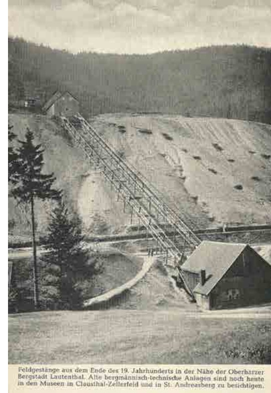
Resim 10 - 19. Yüzyıl sonunda Oberharz (Yukarı Harz) bölgesinde Lautenthal şehri yakınlarında eski maden tekniğini gösteren resim. Kuyudaki su pompalarını ve “Hareketli Merdivenleri” çalıştıran gücü çarktan kuyuya ileten çubuk tesisleri halen Clausthal - Zellerfeld’de ve St. Andreasberg maden müzelerinde görülebilir.
