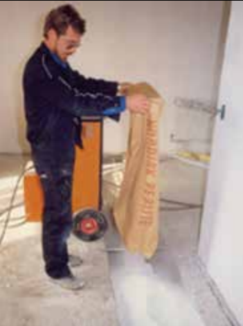
Çatılarda ve duvar aralıklarında gevşek perlit uygulaması
