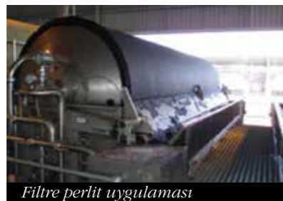
Filtre perlit uygulaması
