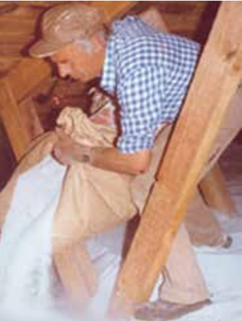
Çatılarda ve duvar aralıklarında gevşek perlit uygulaması
