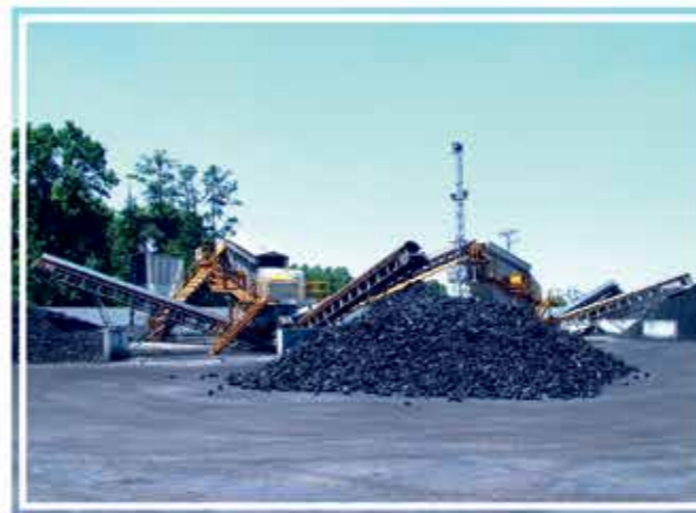
KÖMÜR ELEME ve SINIFLANDIRMA TESİSLERİ
