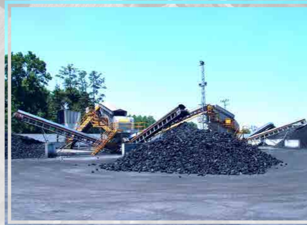
KÖMÜR ELEME ve SINIFLANDIRMA TESİSLERİ
