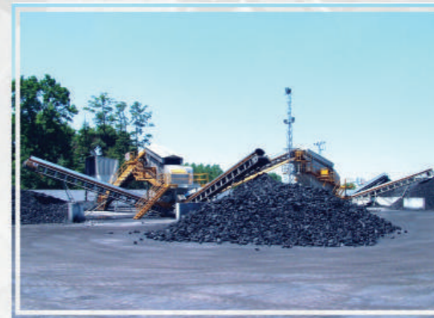
KÖMÜR ELEME ve SINIFLANDIRMA TESİSLERİ
