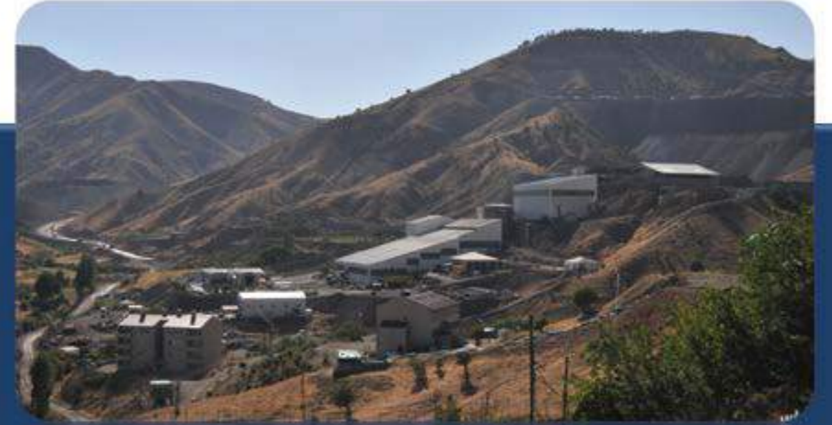
Siirt Bakır Konsantratör Tesisi ve Bakır Madeni Sahaları
