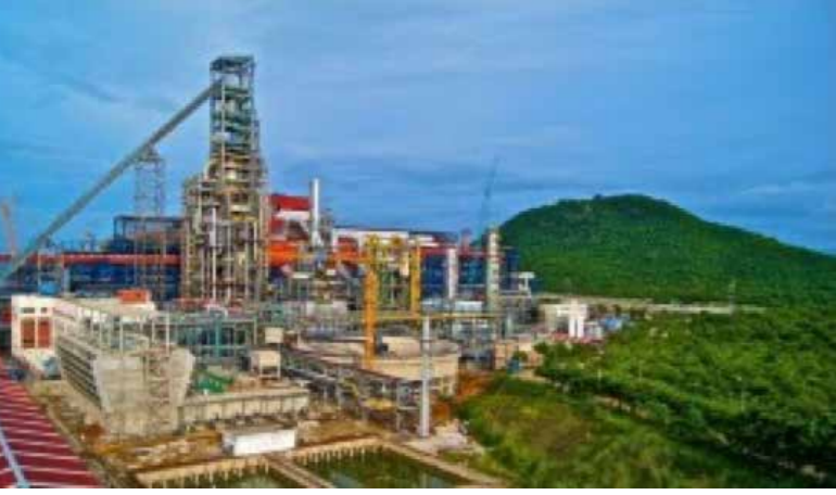
Sentez Gazı kullanan DRI tesisi - Angul, Orissa, Hindistan
