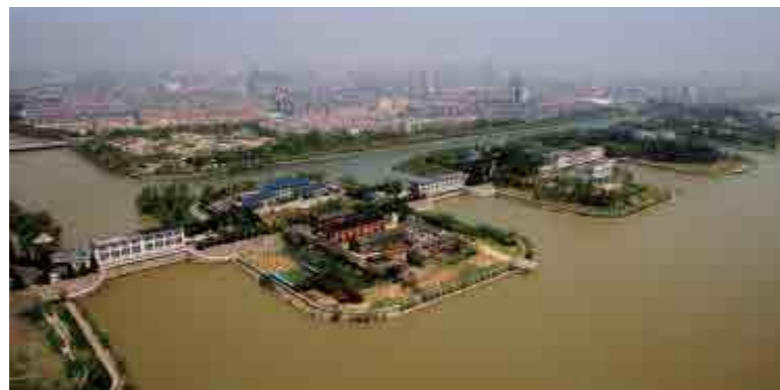
Resim 14: Jiangdu Pompa İstasyonu
