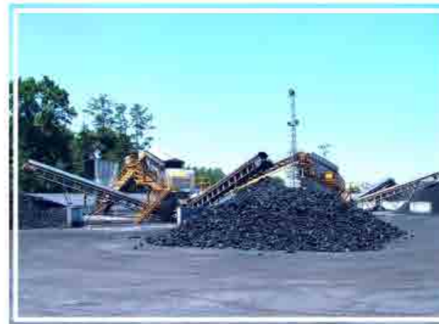
KÖMÜR ELEME ve SINIFLANDIRMA TESİSLERİ
