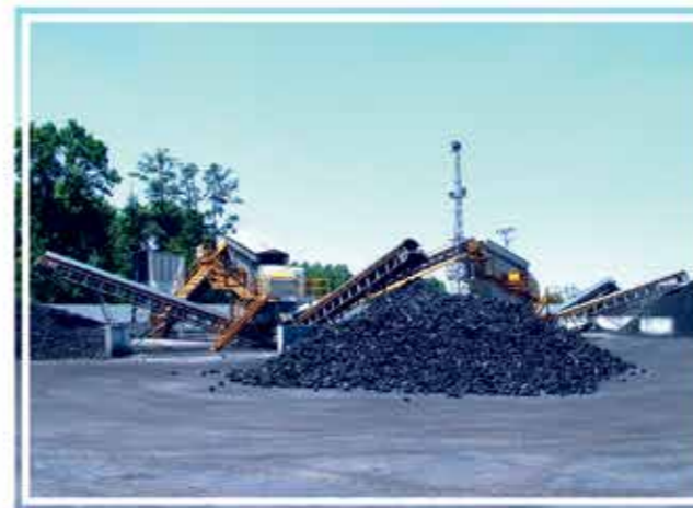
KÖMÜR ELEME ve SINIFLANDIRMA TESİSLERİ
