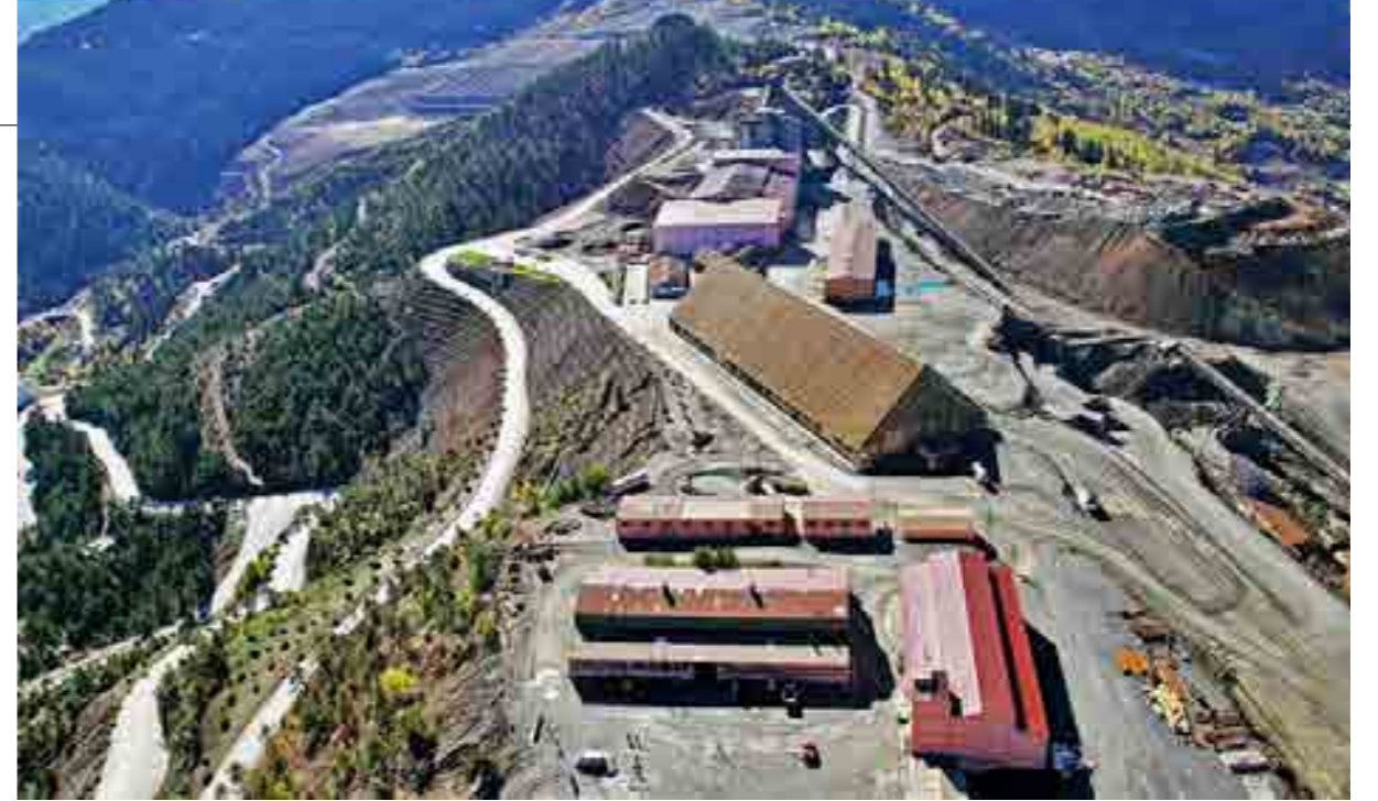
Resim 6 - Eti Bakır Küre Bakır İşletmesi Tesisleri
